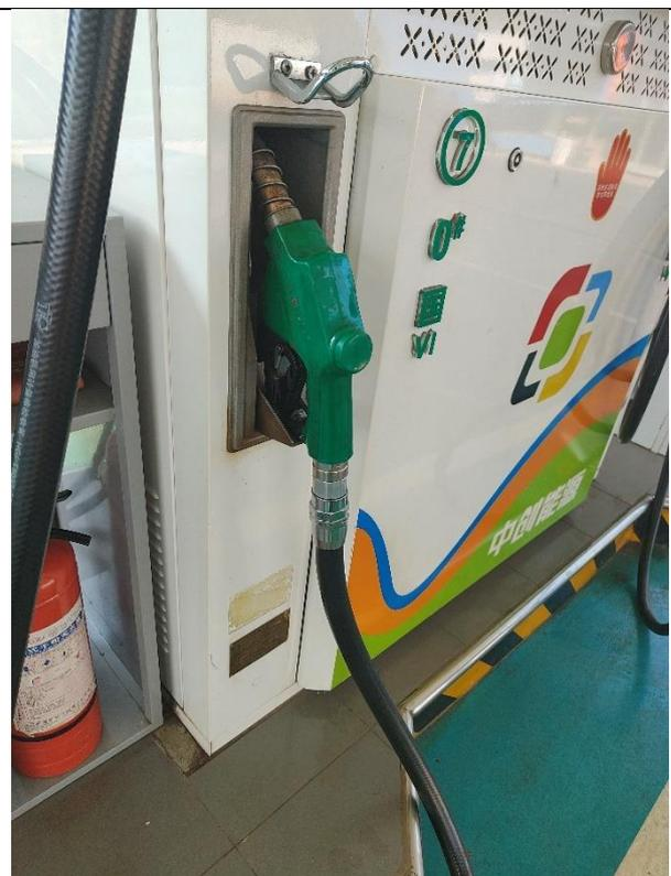
图 2-18、图 2-19 加油机拉断阀
