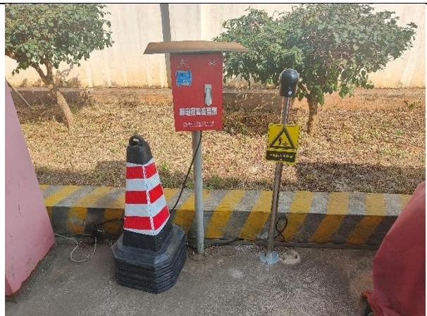
图 2-26 静电接地装置、人体静电释放装置
